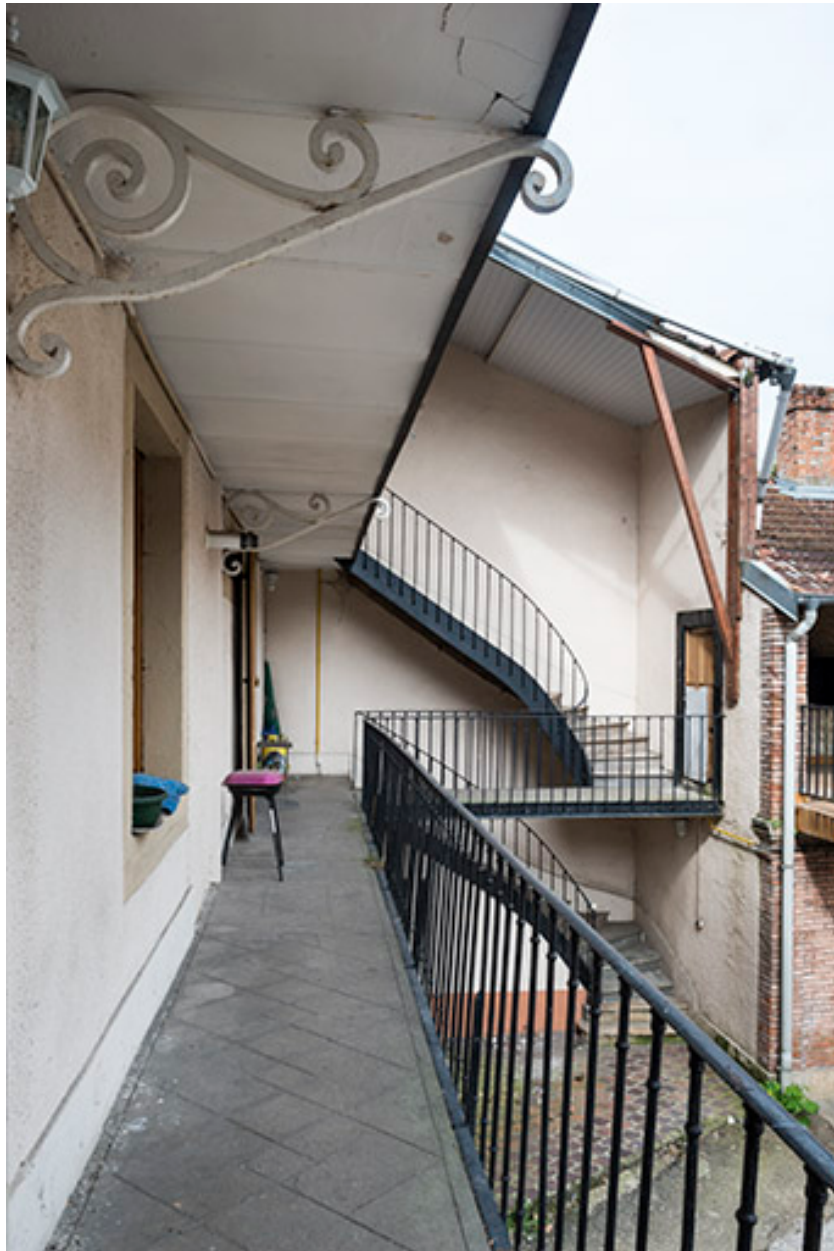
Escalier à cage ouverte, façade postérieure.
