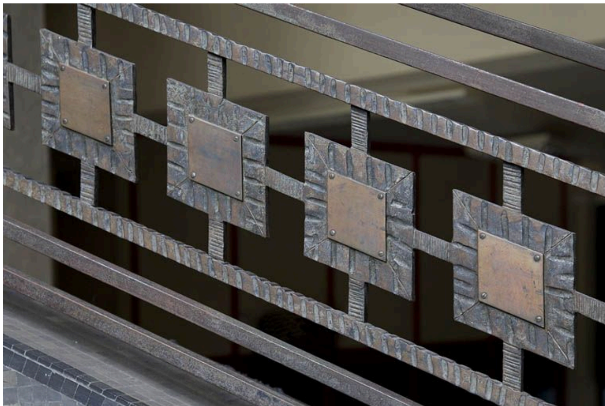
Bâtiment B : rampe de l'escalier tournant.
