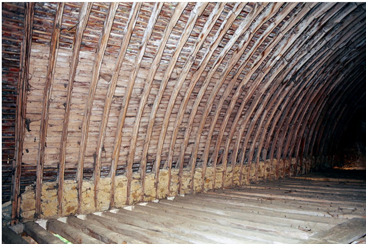
Charpente du séchoir.
