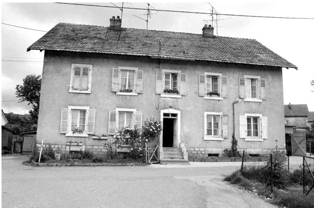
Maison ouvrière à quatre logements en 1980.
