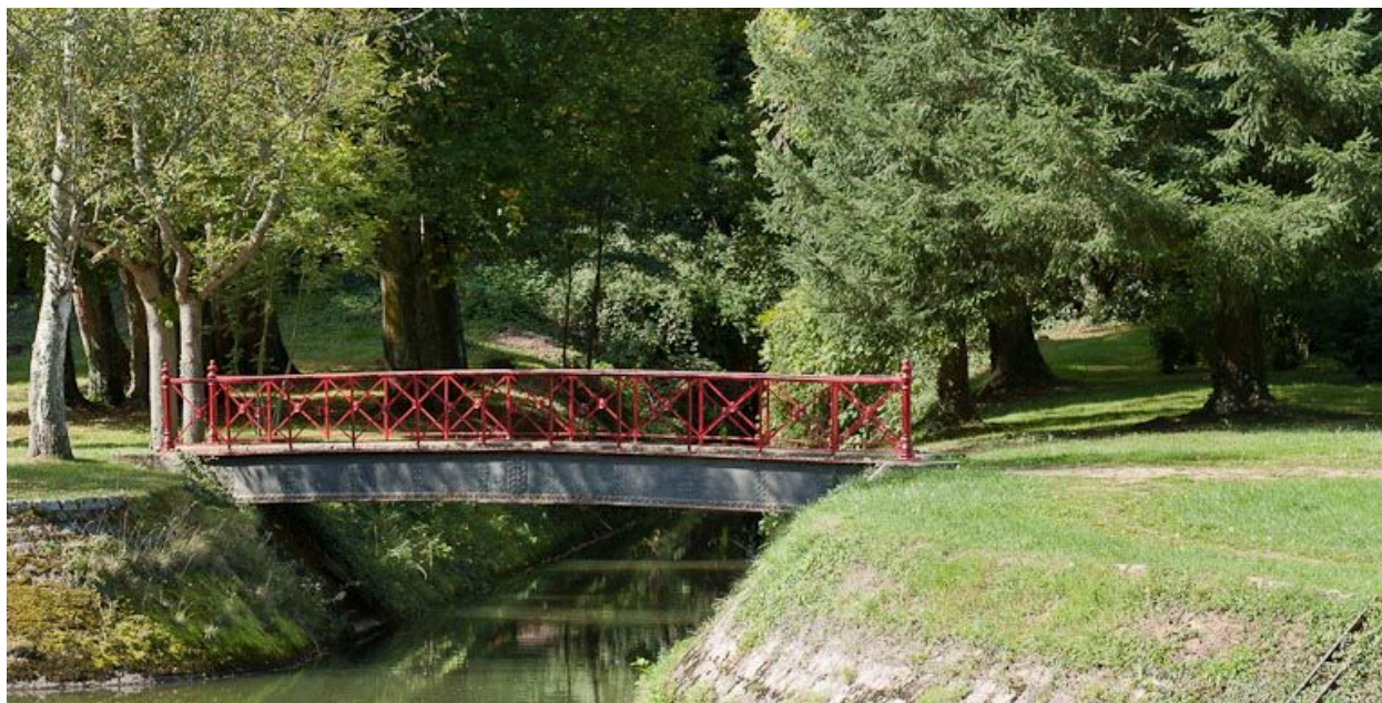
Vue d'un pont sur rigole.
