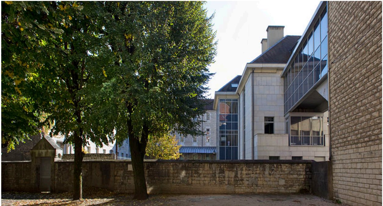
Vue latérale du bâtiment Charvet et de la passerelle depuis la cour du lycée située devant le bâtiment Ducat.
