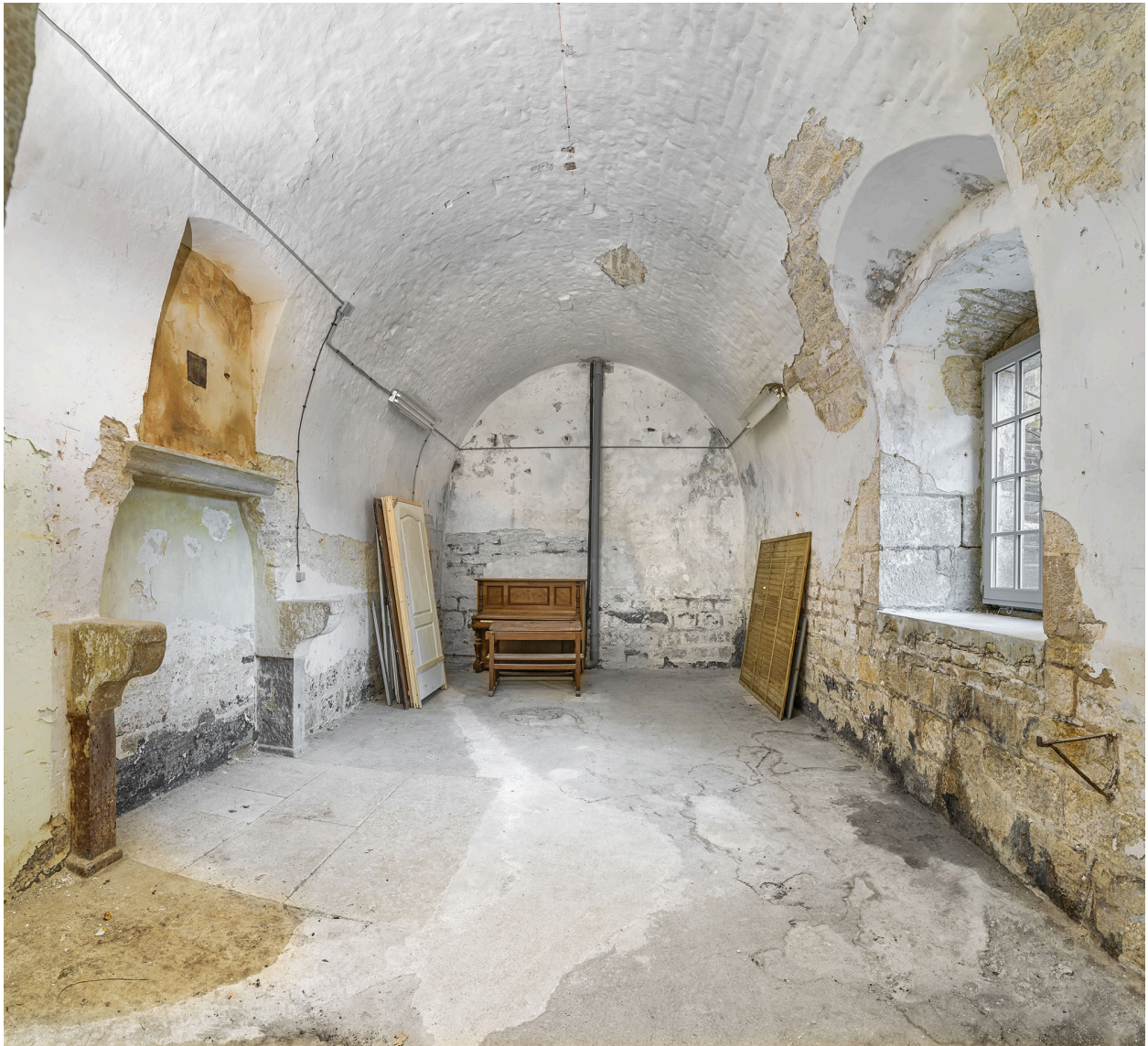
Pavillon d'entrée : pièce du petit corps de garde.
