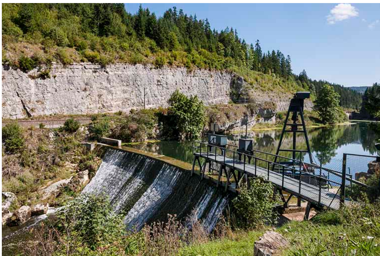
Le barrage depuis la rive gauche.
