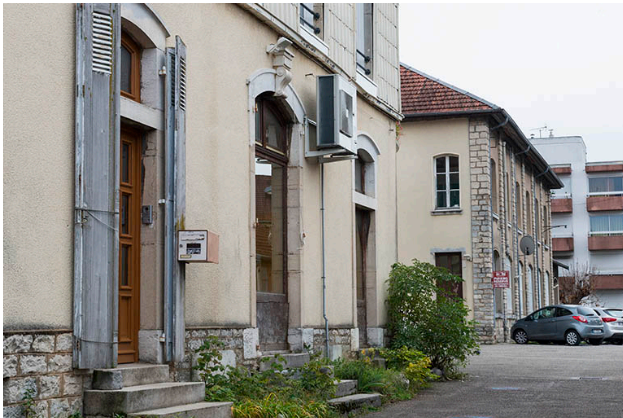
Vue depuis l'entrée. Logement et atelier.
