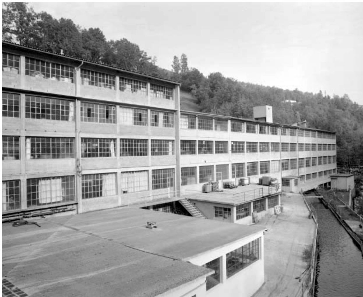
Façade postérieure des ateliers de fabrication.
