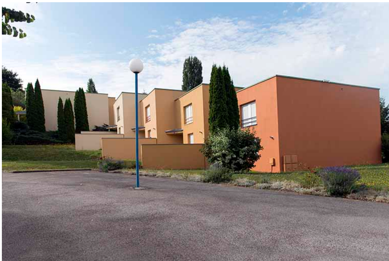
Façade antérieure nord-est des logements.
