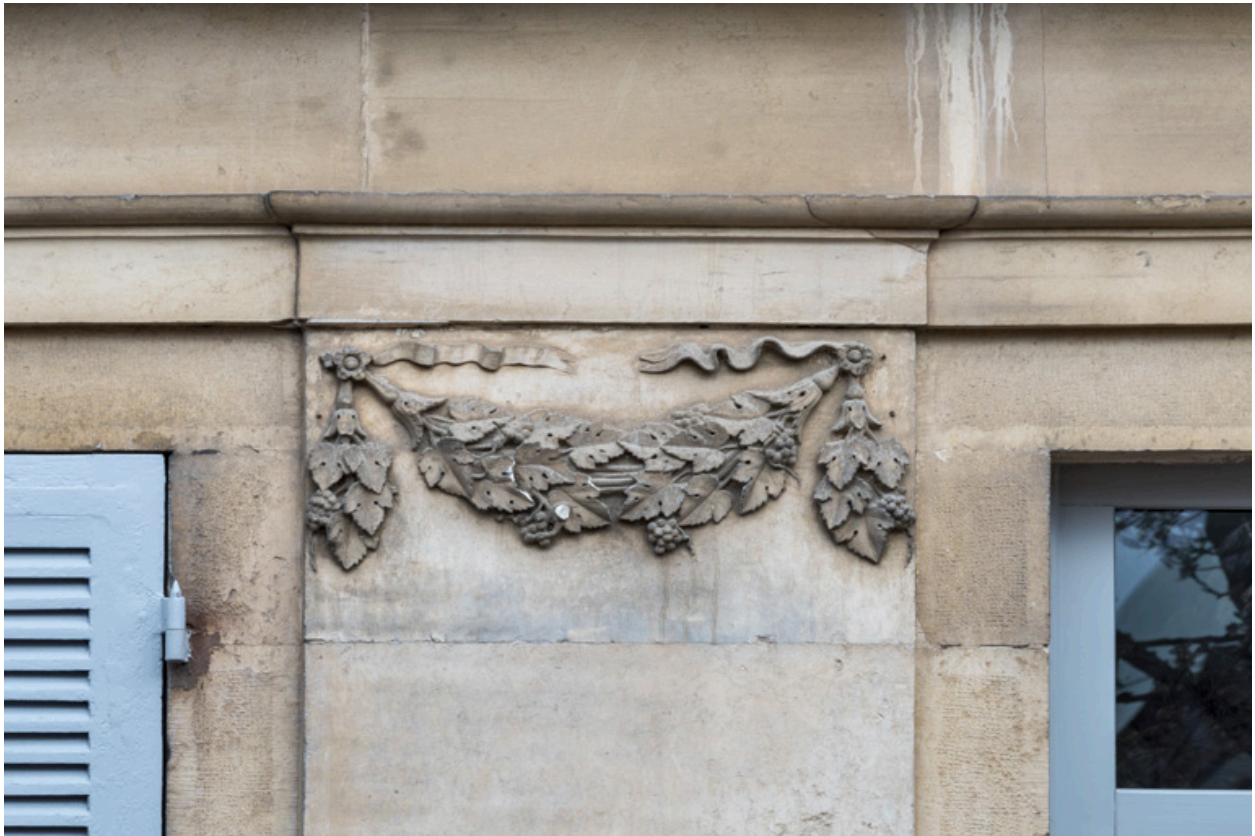
Façade latérale gauche, 2e pilastre (en partant de la gauche) : guirlande sculptée.
