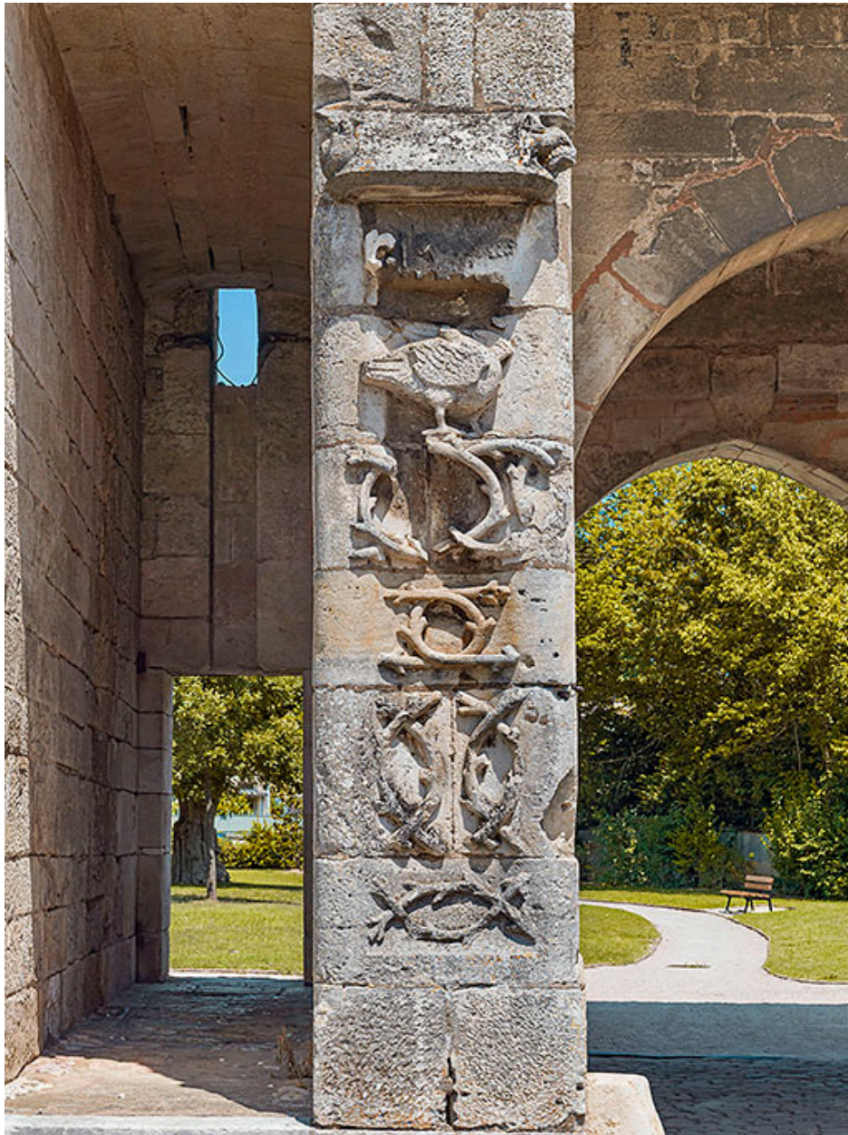
Pilier séparant les parties piétonne et cochère de la porte, côté ville.
