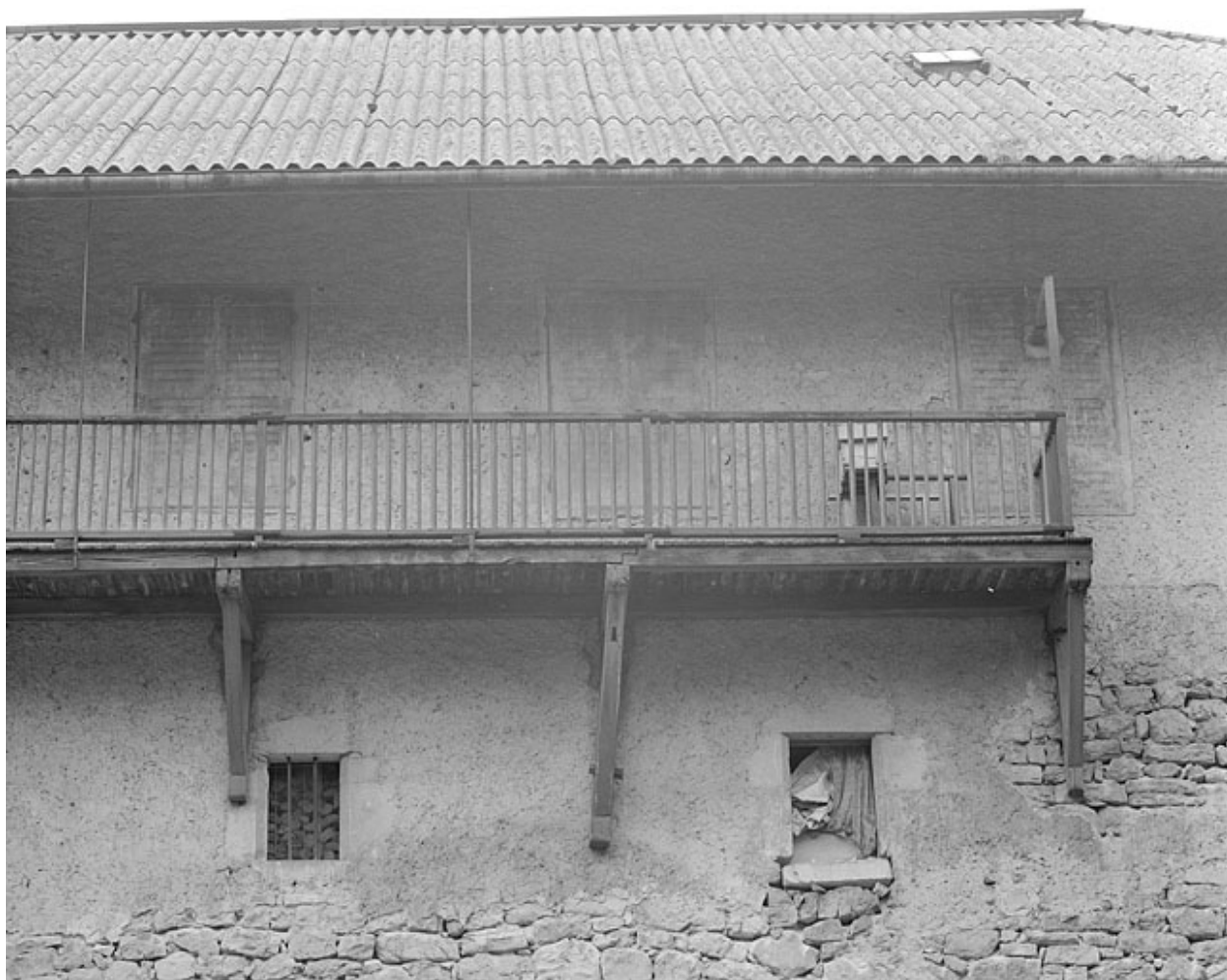
Détail de la façade postérieure.
