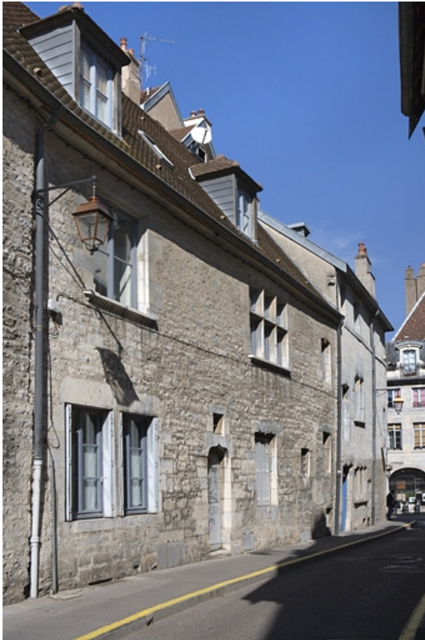
Façade latérale gauche, vue partielle.
