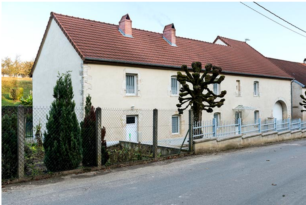
Ferme-bloc, 10-14 rue de la Garenne.
