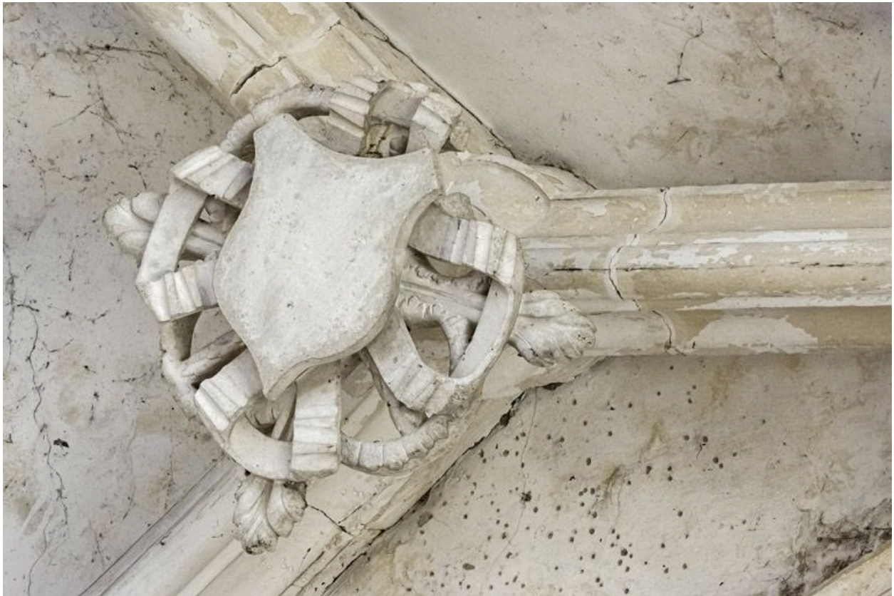
Intérieur de la chapelle : clef de voûtes.
