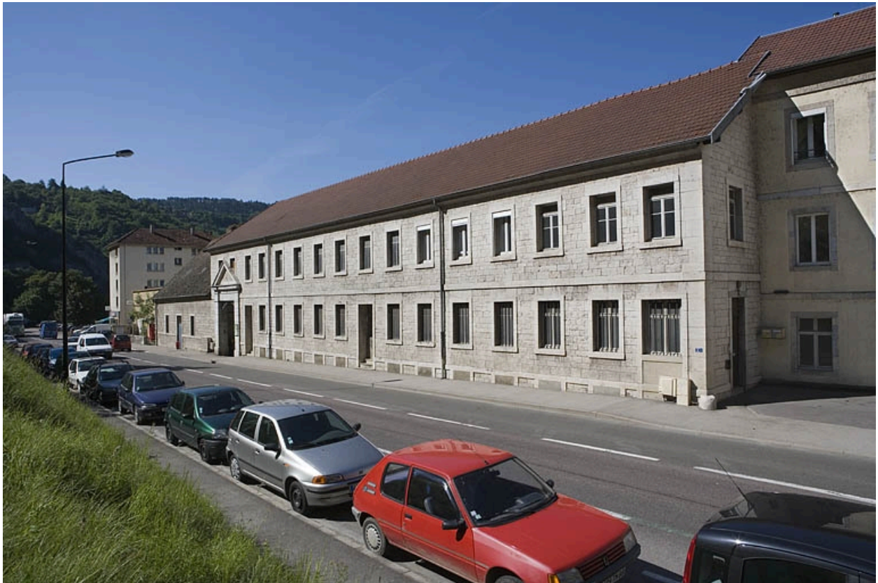
Façade antérieure de l'ancien moulin, de trois quarts droite.
