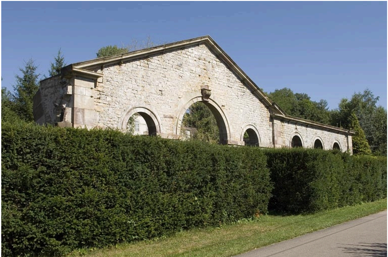
Façade antérieure de l'atelier du haut fourneau.
