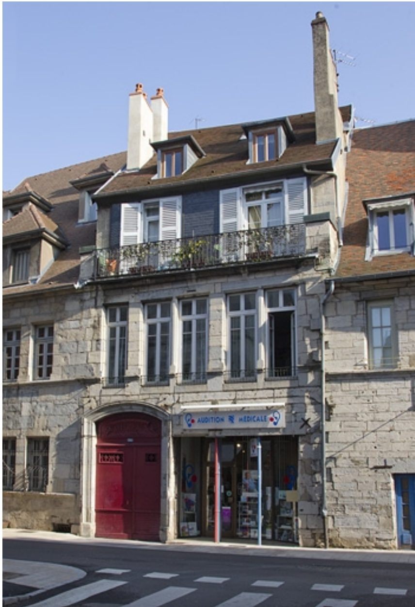
Vue d'ensemble depuis la rue.
