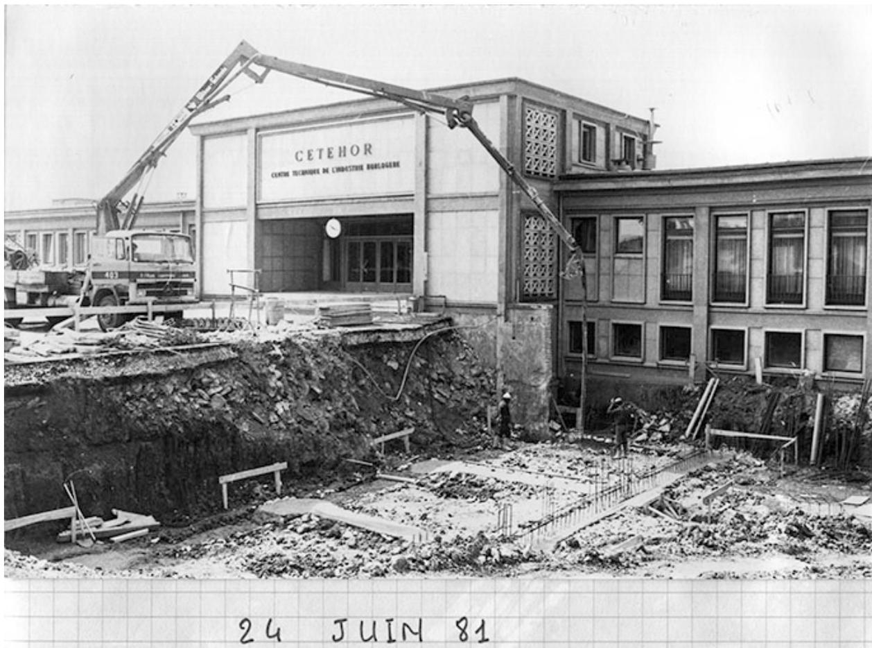
[Construction du laboratoire de métrologie, fondations : coulage du béton], 24 juin 1981.
