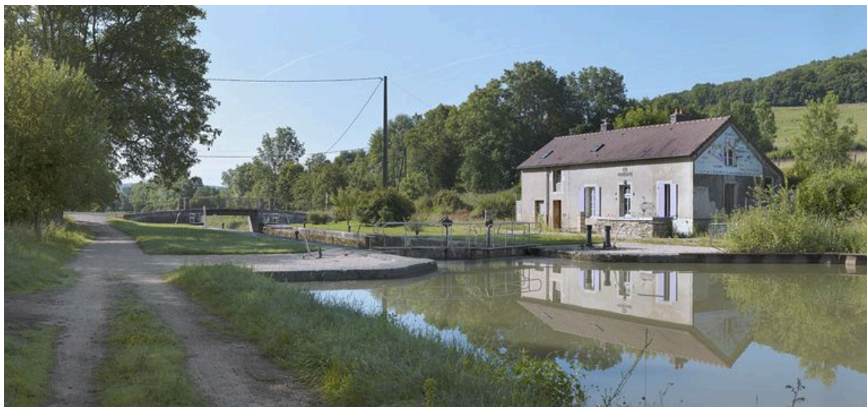
Site d'écluse vu d'amont.
