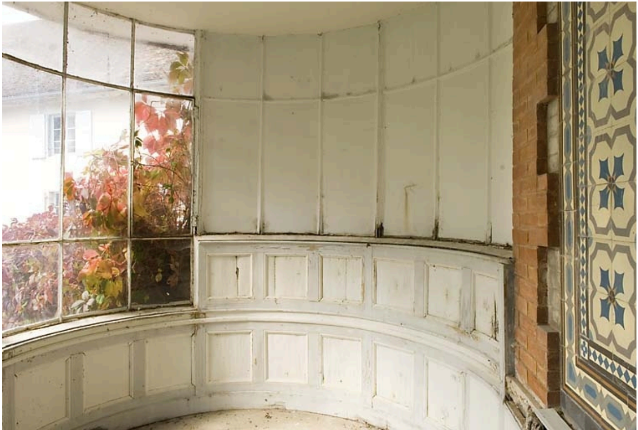
Serre : intérieur (extrémité nord-ouest).
