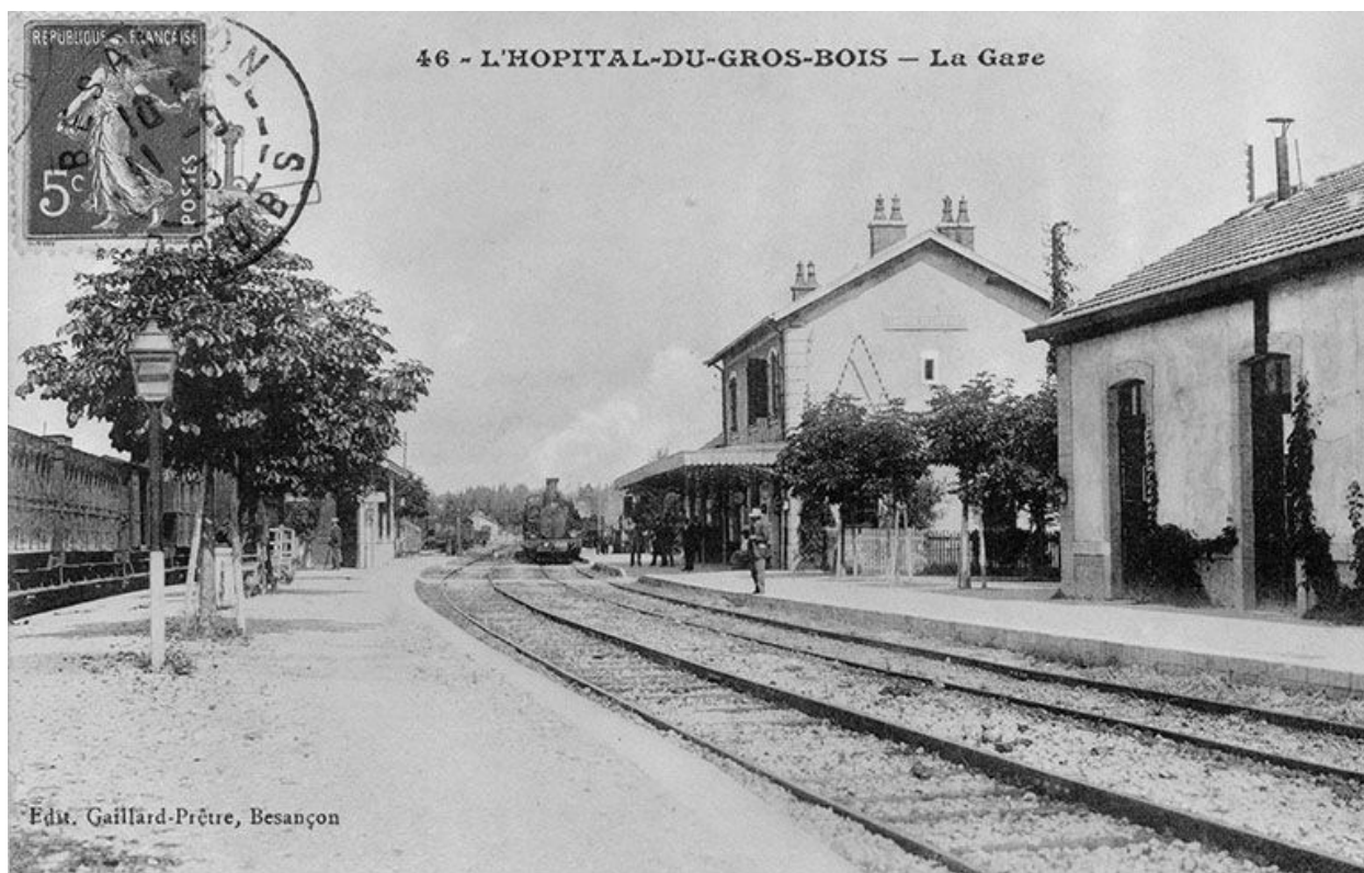
L'Hôpital-du-Grosbois - La Gare, 1913.
