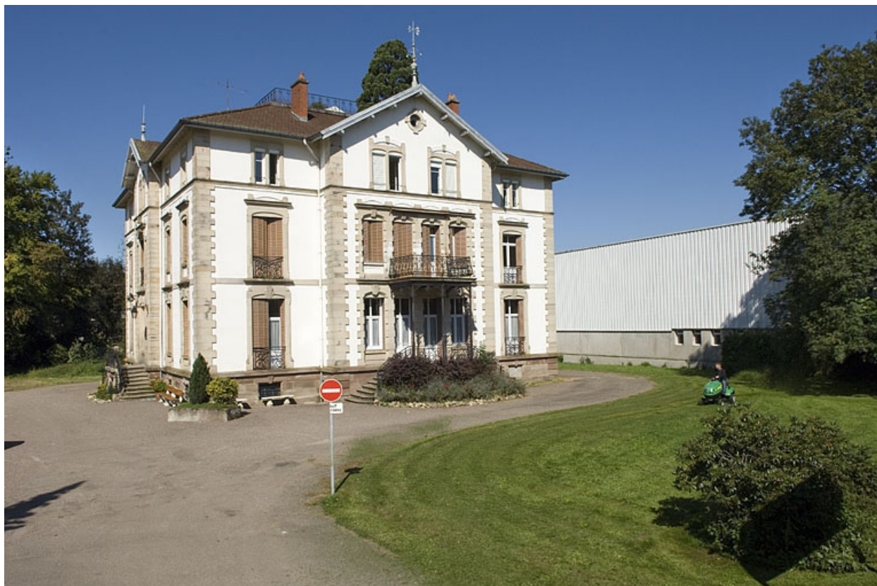
Logement patronal. Vue de trois quarts.
