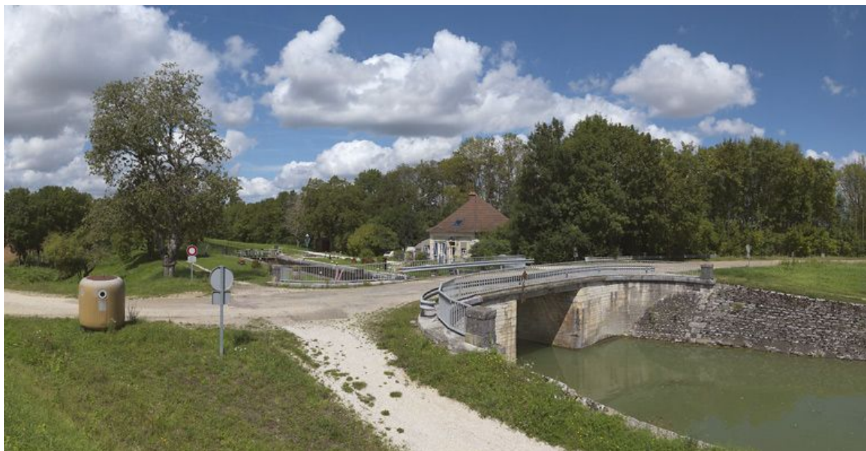
Vue d'ensemble du site, pris d'aval.
