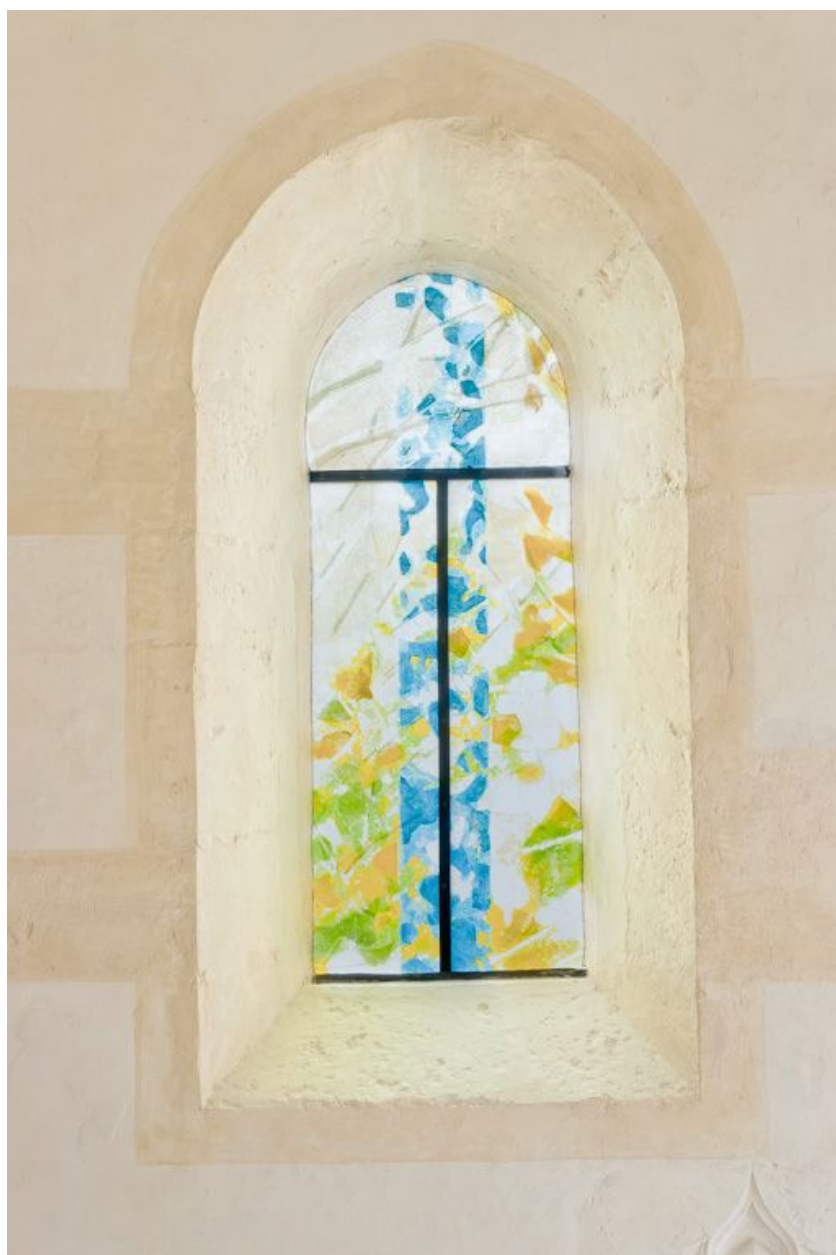
Détail de la baie et de son vitrail, mur droit.
