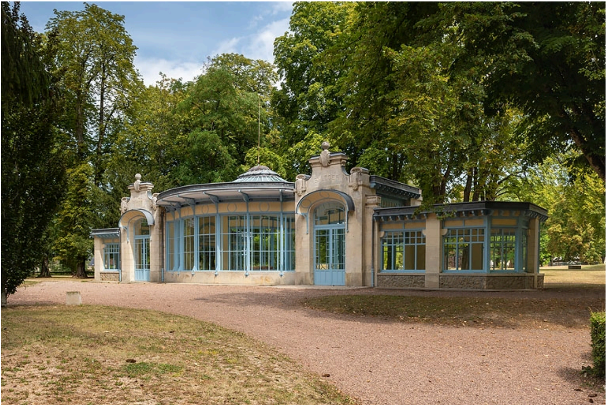
Façade ouest, vue en 2020.
