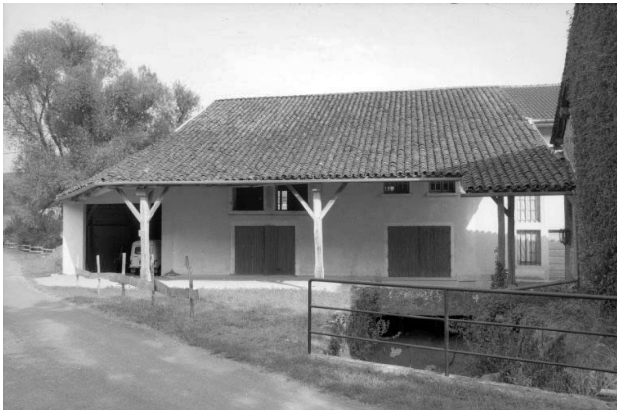
Canal d'amenée et auvent.
