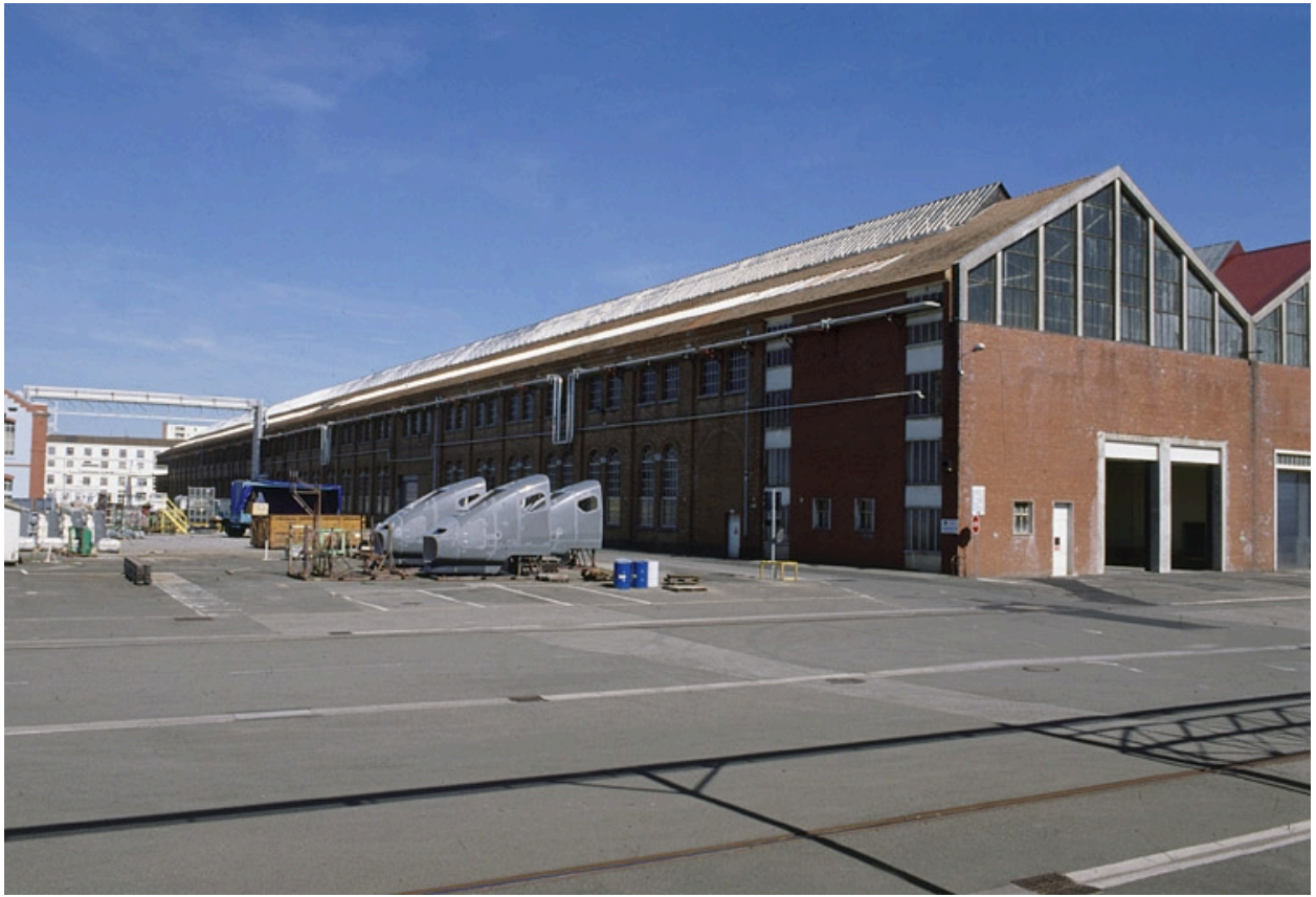
Façade nord de l'atelier Traction.
