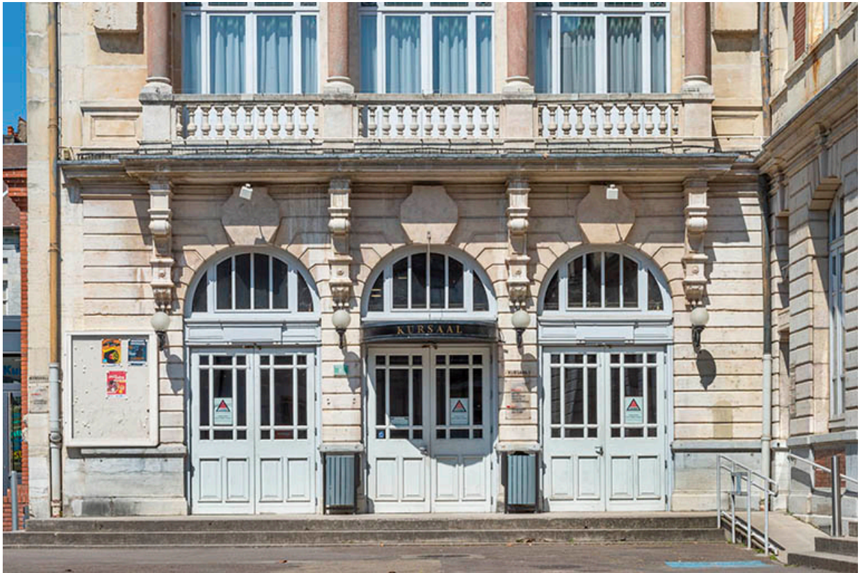
Bâtiment d'entrée, façade antérieure : rez-de-chaussée.
