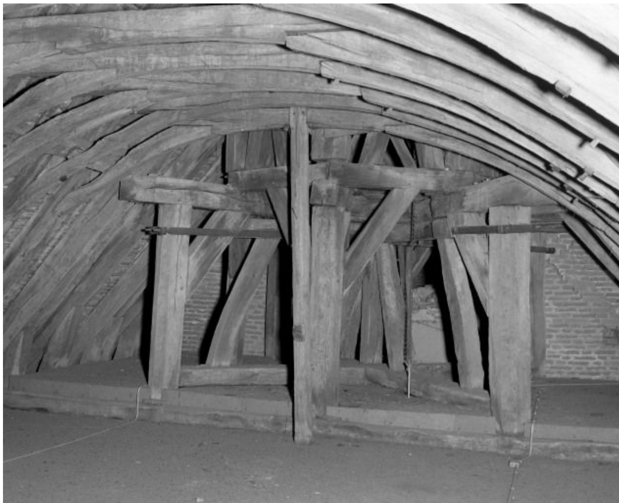
Charpente du comble et beffroi
