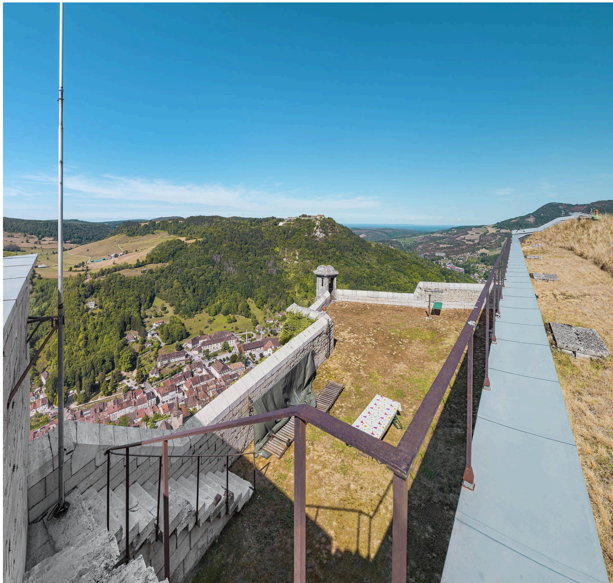
Escalier extérieur de la façade postérieure.
