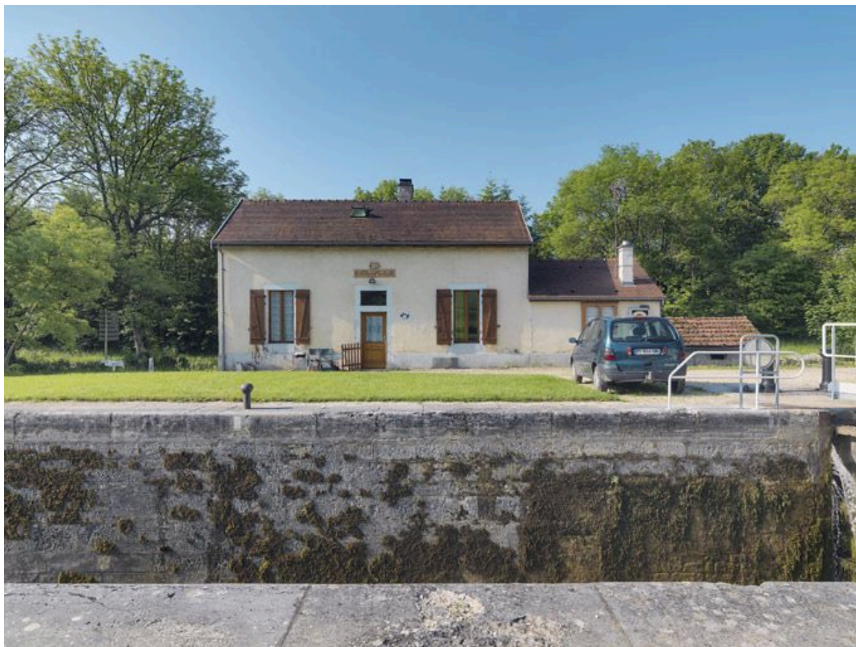
La maison éclusière de face.
