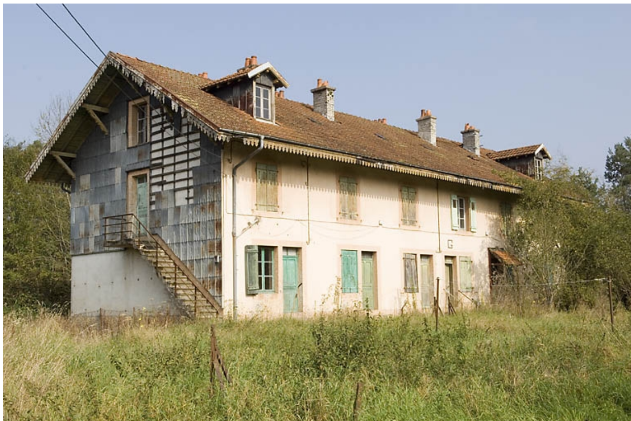
Maison G de la cité ouvrière.
