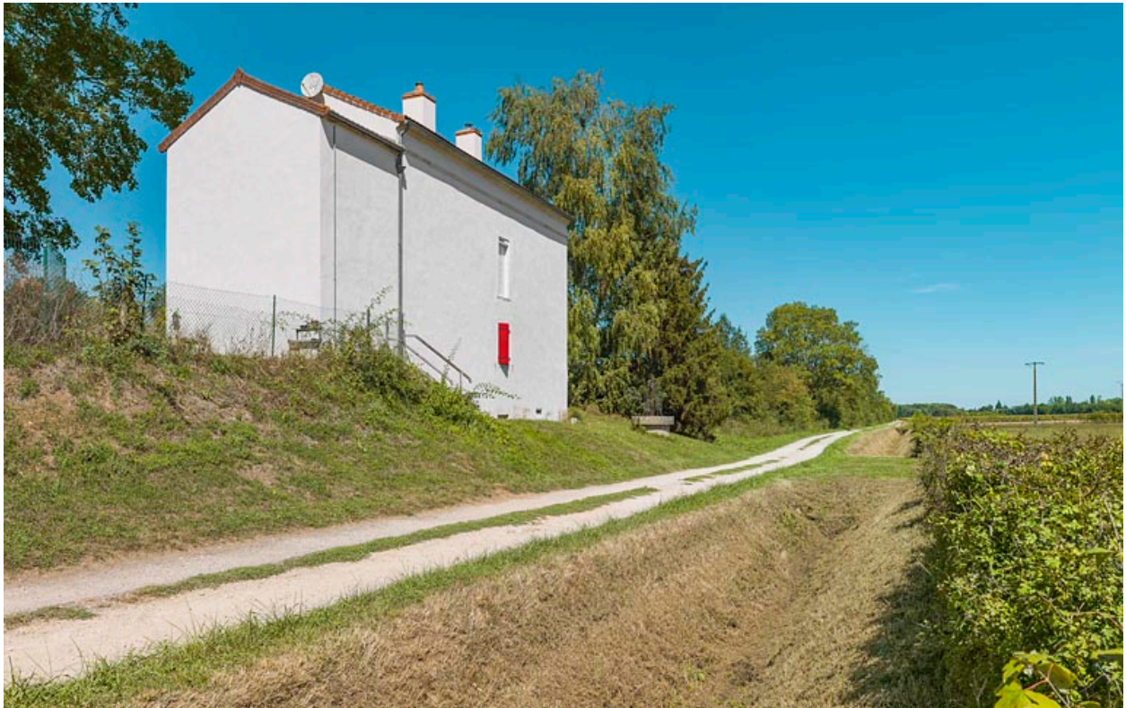
La maison éclusière de 3/4 : pignon de l'annexe latérale droite et face arrière.
