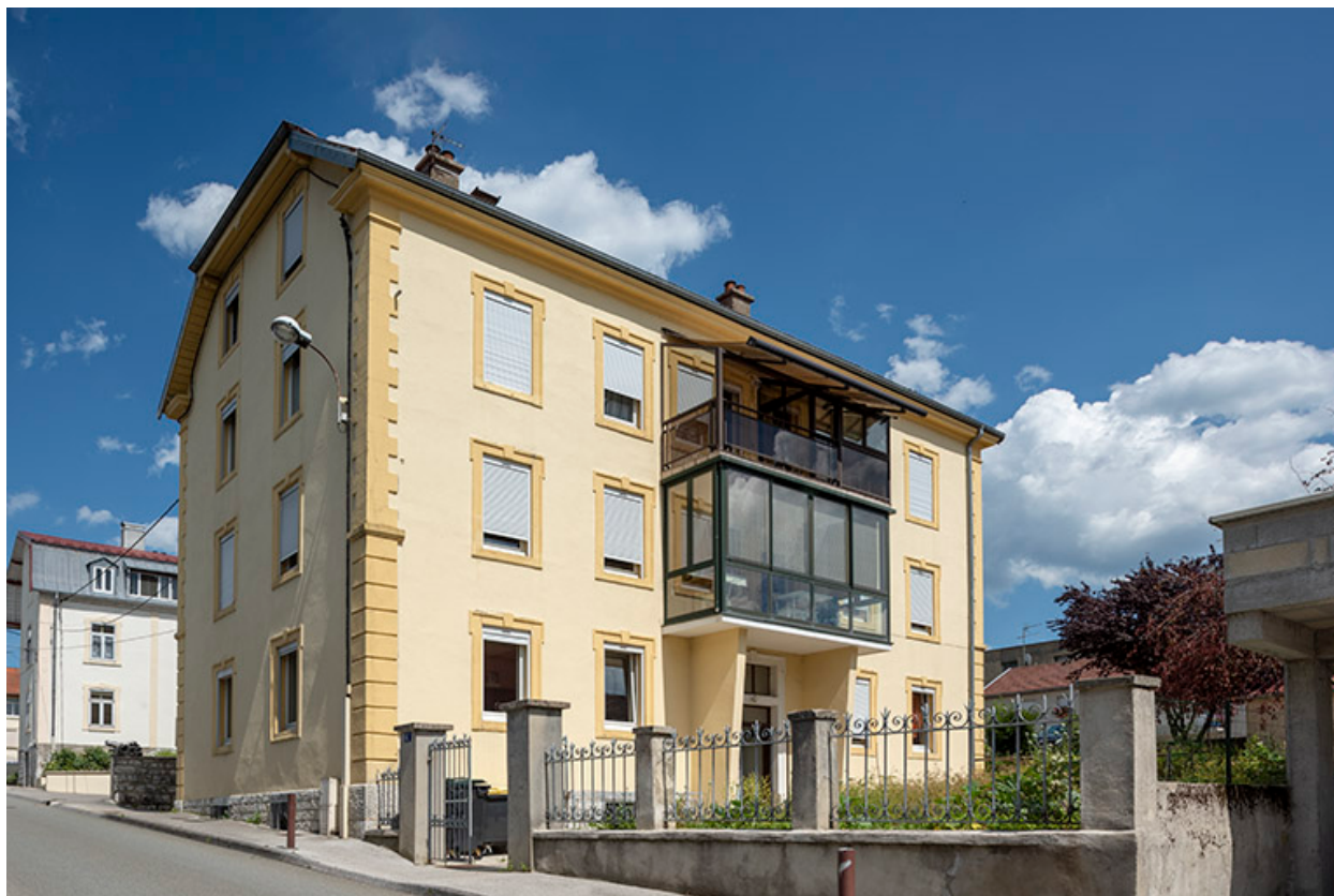
Façades antérieure et latérale gauche.
