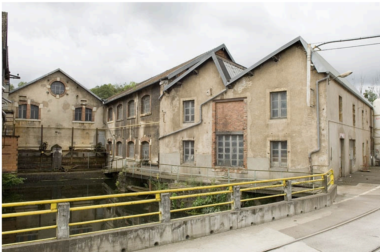
Bief d'amenée, bâtiment d'eau et atelier.
