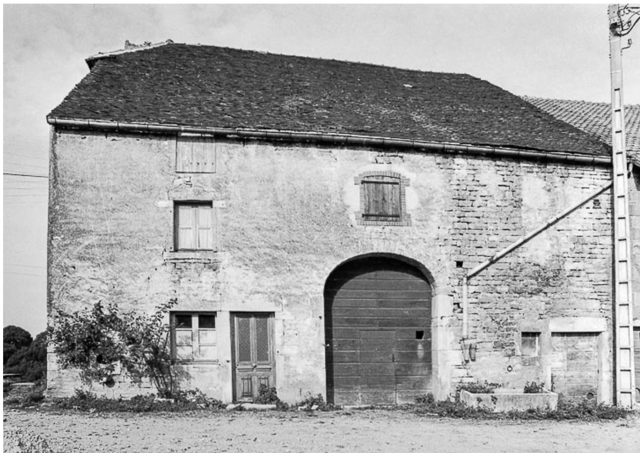
Ferme cadastrée D2 275 : façade antérieure.
