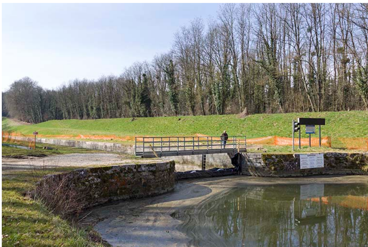
Entrée amont menant au tunnel.
