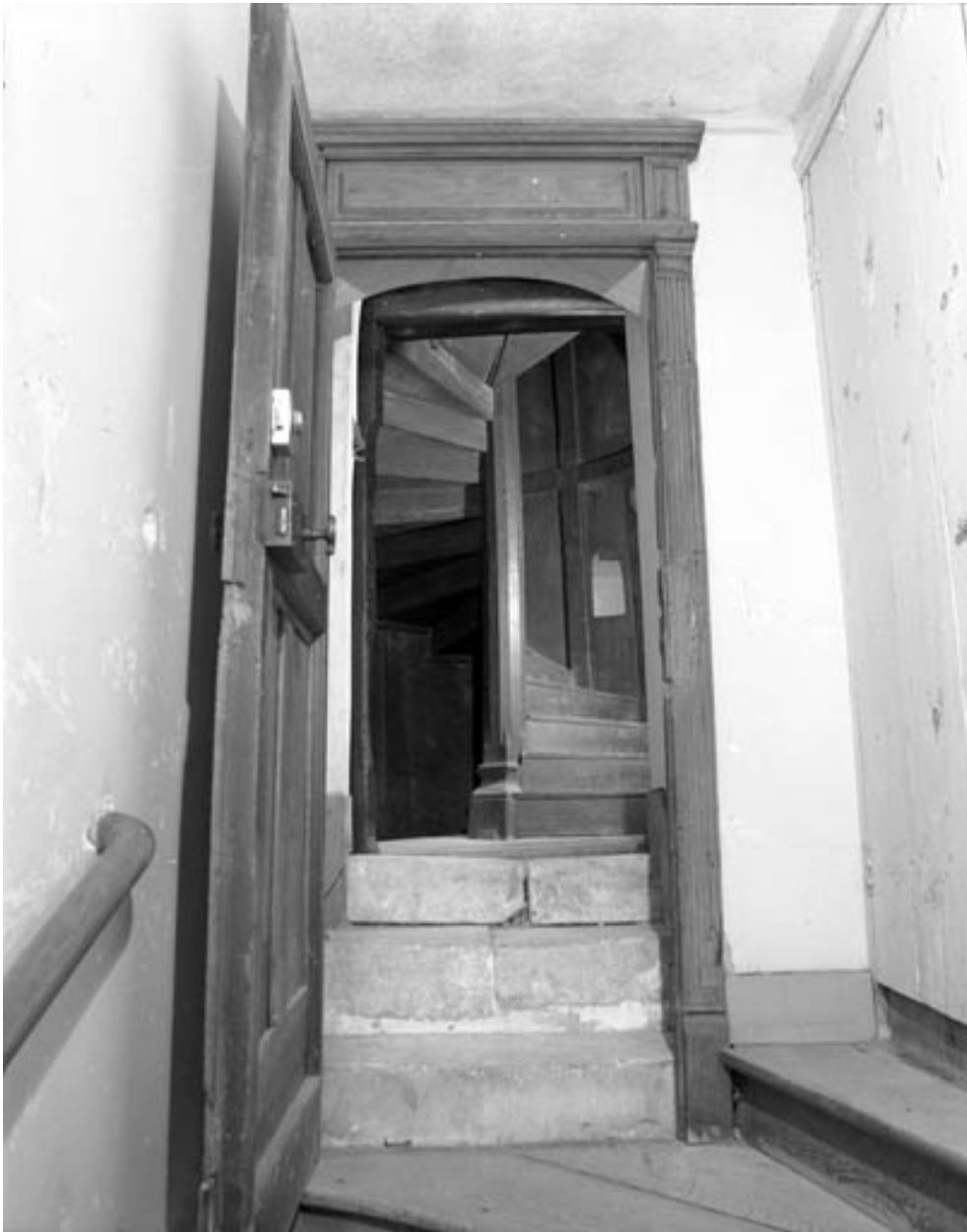
Porte d'entrée ouverte montrant l'escalier en vis contenu dans le cylindre pivotant.
