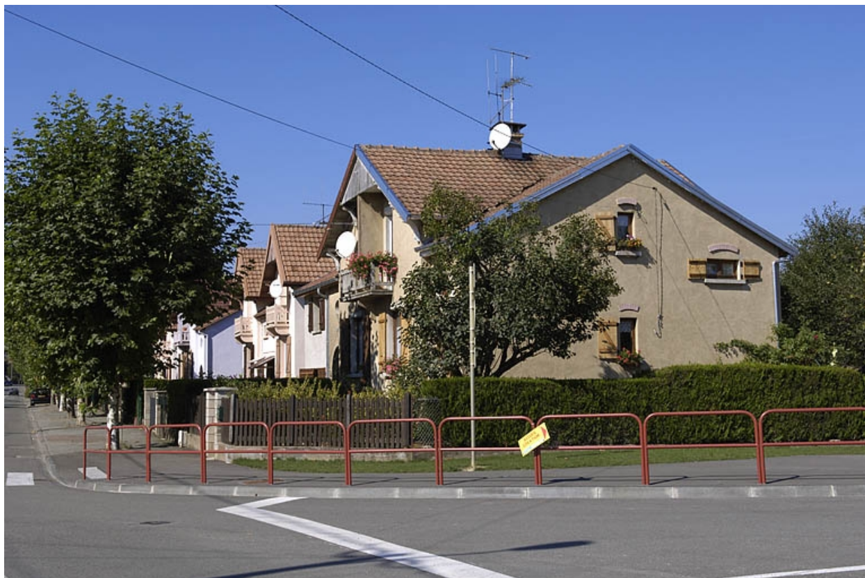
Logements ouvriers faubourg de Montbéliard.
