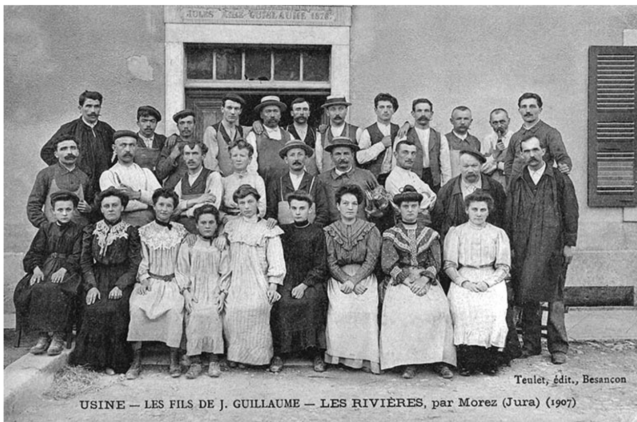
Usine - Les Fils de J. Guillaume - Les Rivières, par Morez (Jura) (1907).
