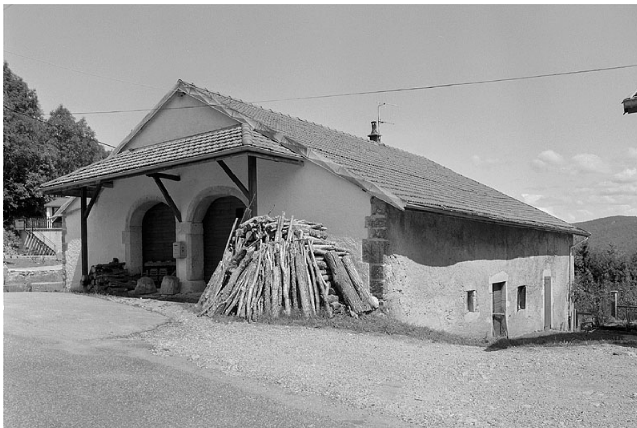
Façade postérieure et face sud.
