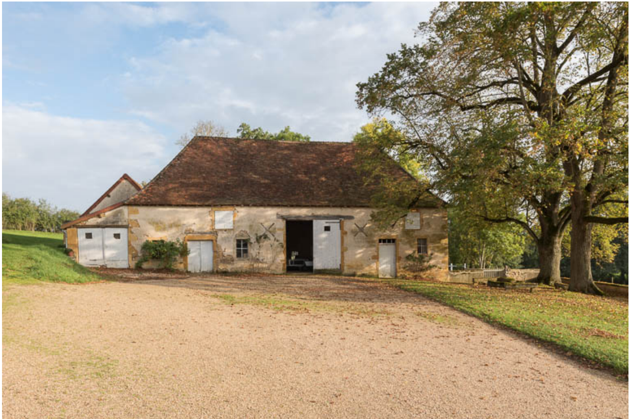
Façade antérieure de la grange
