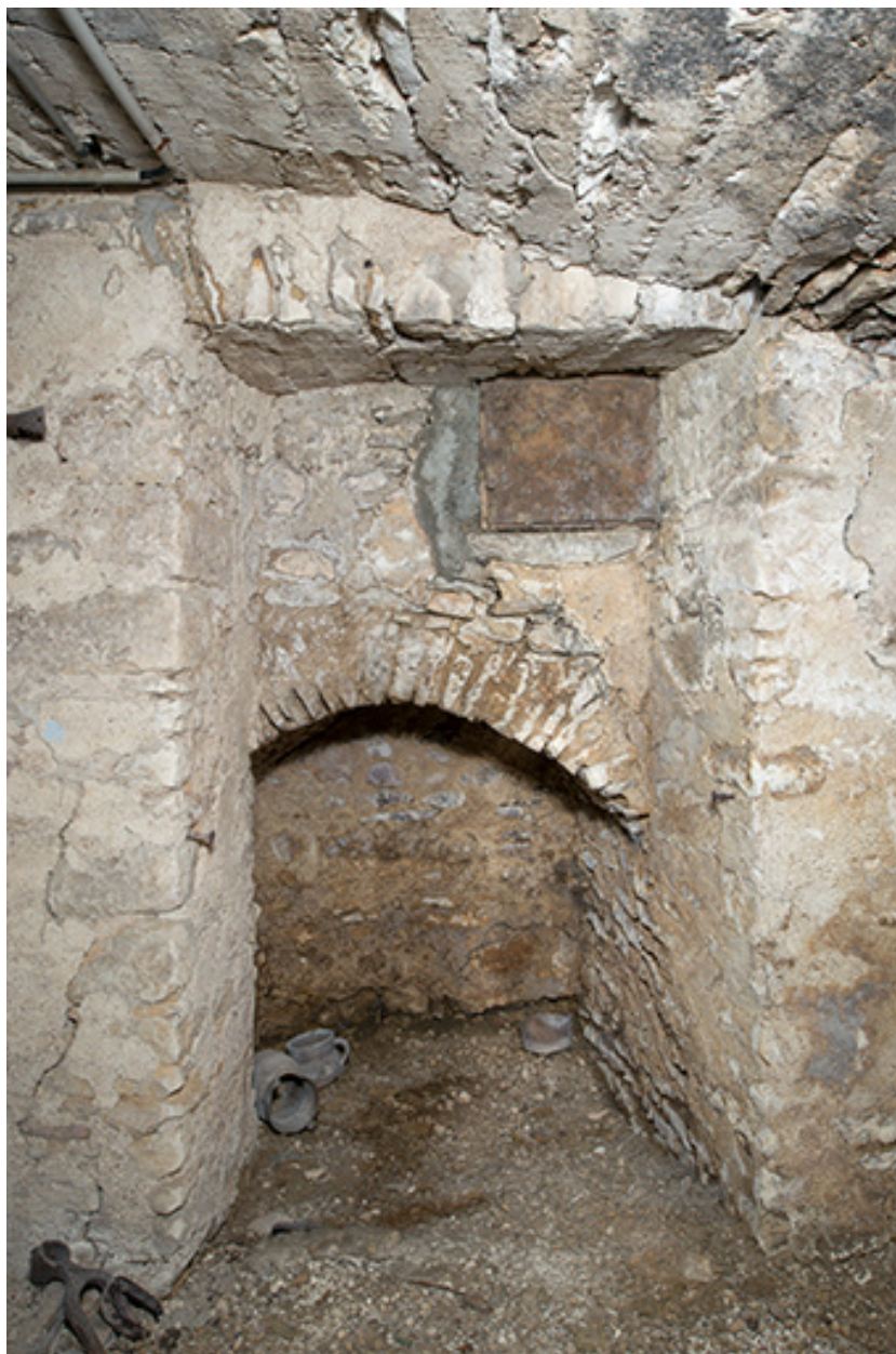
Le cellier, détail de la voûte supportant l'escalier extérieur.
