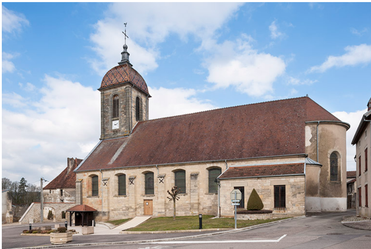
Vue de la façade sud.
