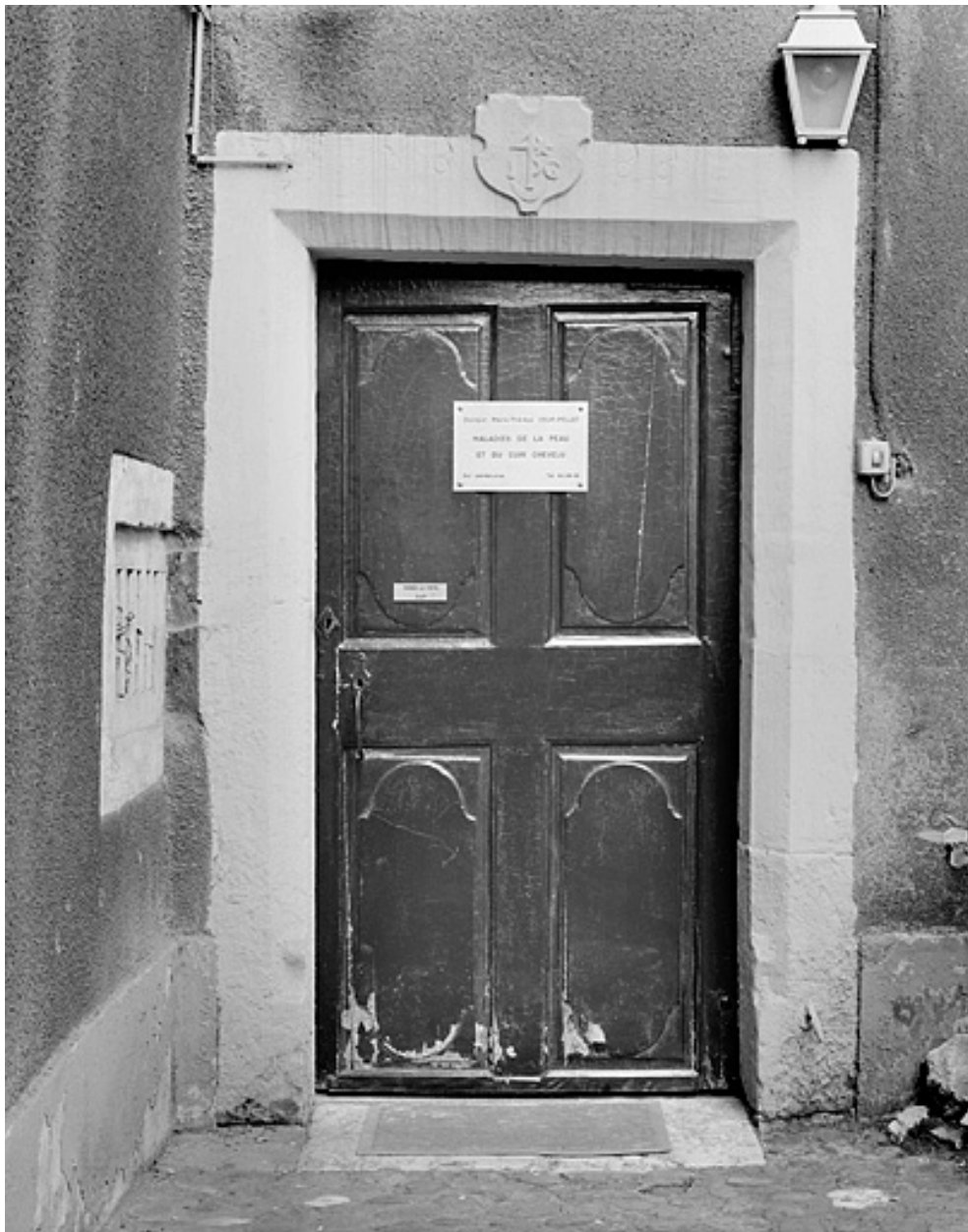
Porte de la tour d'escalier.
