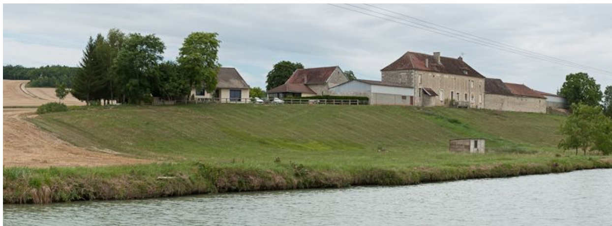
Vue du site depuis le canal.
