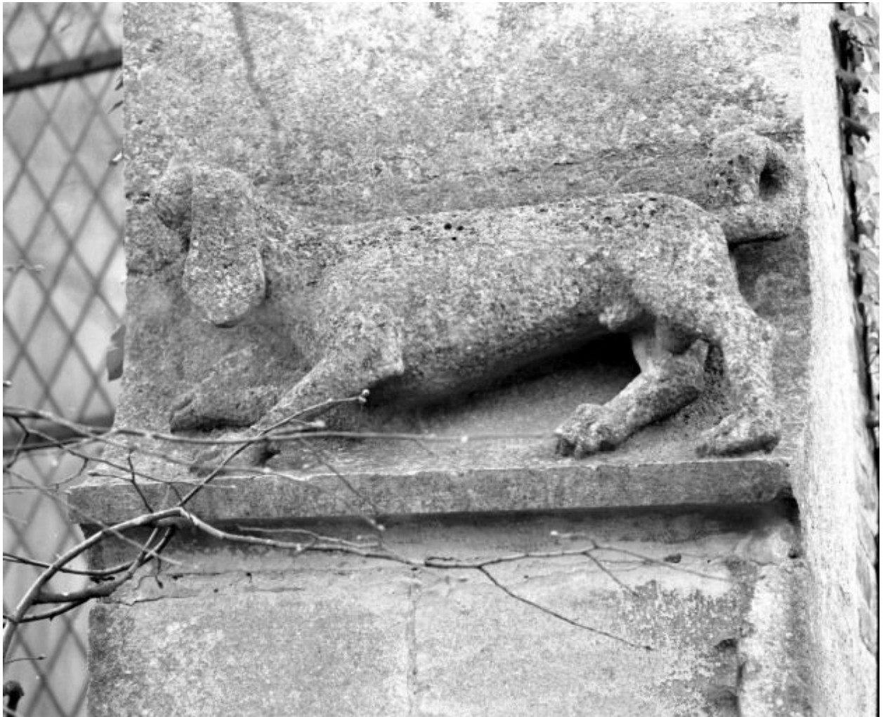
Chien sculpté sur le larmier du contrefort droit du chœur.
